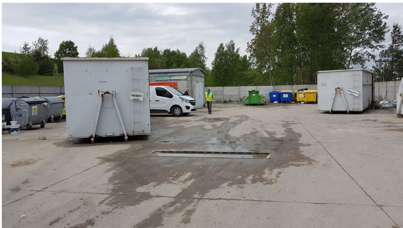
Fotografia nr 7 Widok na istniejącą instalację PSZOK (maj 2021).
