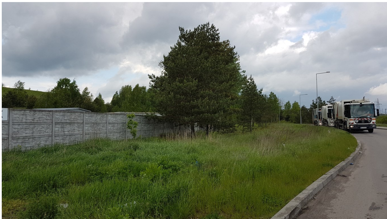
Fotografia nr 1 Widok na północno-wschodnią część analizowanego obszaru (maj 2021).
