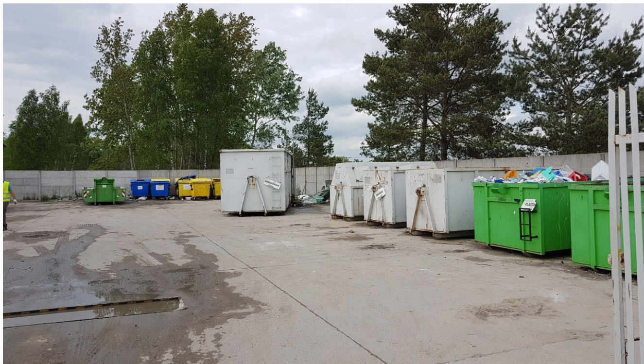
Fotografia nr 8 Widok na istniejącą instalację PSZOK (maj 2021).
