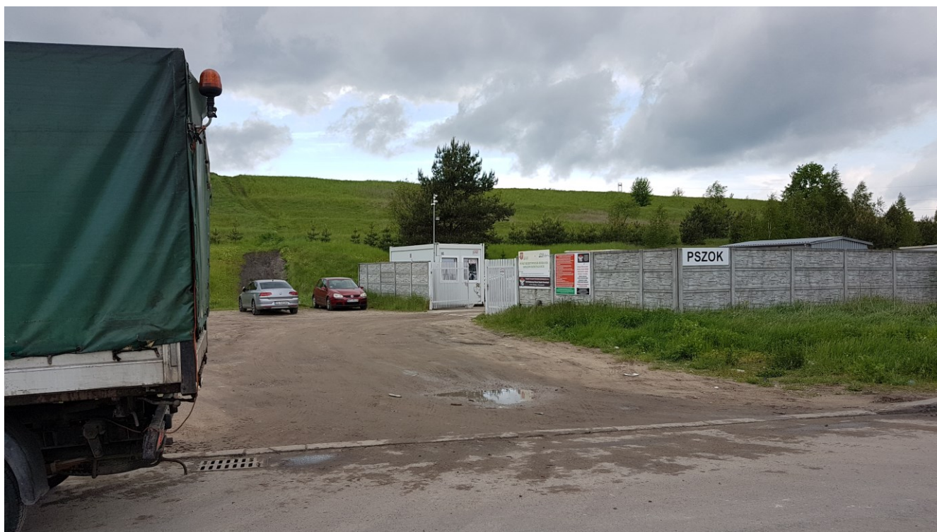
Fotografia nr 9 Widok na istniejącą instalację PSZOK (maj 2021).
