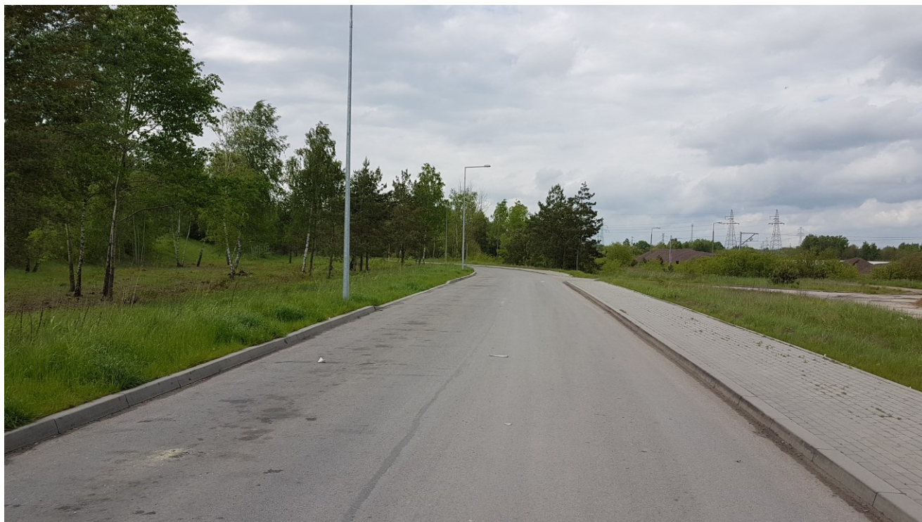
Fotografia nr 6 Widok na drogę dojazdową do istniejącego zakładu (maj 2021).
